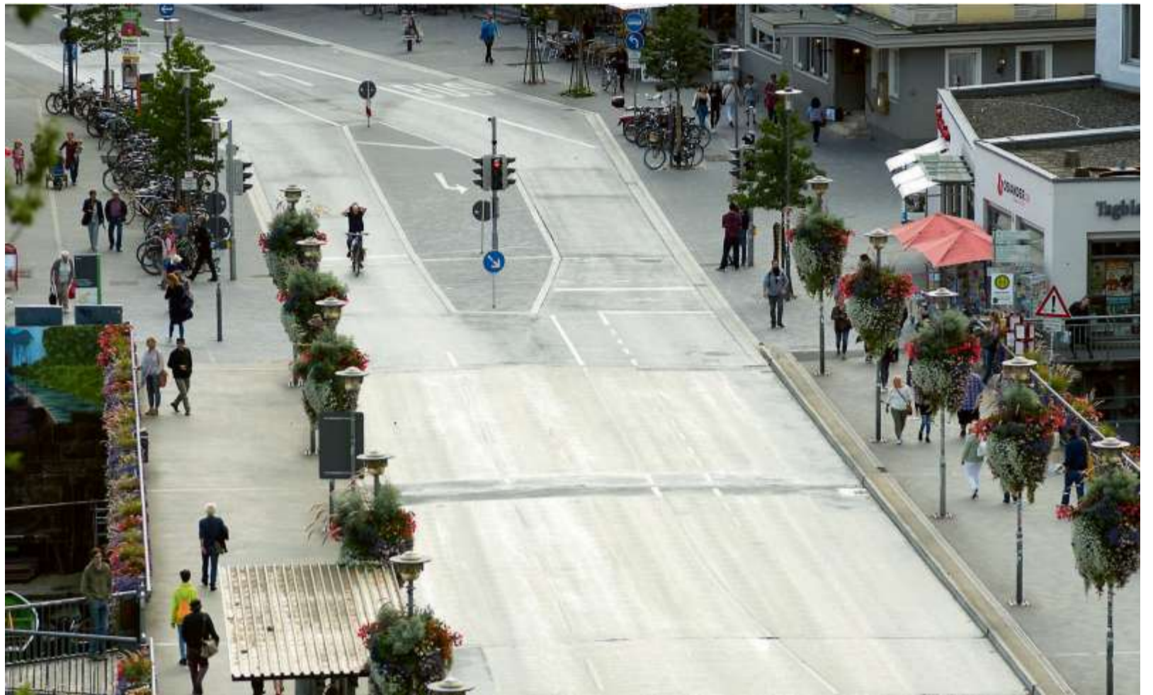
FÜR MANCH RADELNDEN TÜBINGER EIN TRAUM: Die Neckarbrücke als autofreie Zone.
